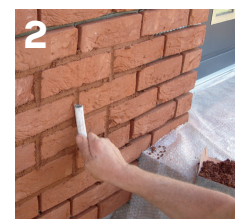
2 Fugakép kialakítása a megfelelő szerszámmal.
