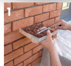
1 Fugák kitöltése fugázó habarccsal.
