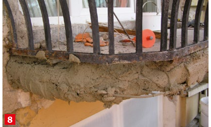
8 A Baumit BetoFill javítóhabarcs vastagsága egy munkamenetben nem lehet több 4 cm-nél. Ennél nagyobb vastagság esetén dolgozzunk a „friss a frissbe” elv szerint. Ha a Baumit BetoFill már megkötött, új réteg nem hordható fel rá. Ilyenkor ezt el kell távolítani és új réteget kell készíteni.
