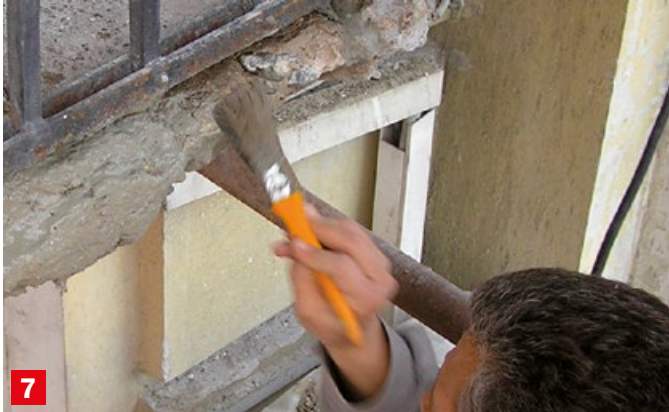
7 Az egész javításra váró felületet töltsük ki a Baumit BetoHaft tapadóhíddal. Ügyeljünk arra, hogy valamennyi furat és üreg gondosan kitöltésre kerüljön.
