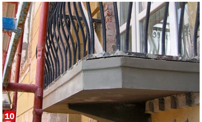
10 Az elkészült felületet védeni kell a túlzottan gyors kiszáradástól (pl. fóliatakarással). Befejező réteggként az elkészült simítás Baumit homlokzatfestékekkel (pl. Baumit NanoporColor) festhető le.
