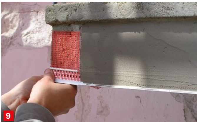
9 A végső felületképzést a Baumit BetoFinish rétege adja, egy rétegben, 3-5 mm vastagságban. A képen az erkélylemez alsó élén a Baumit sarokvédő profil rész kerül beépítésre, a felső Baumit BetoFinish betonglettel van besimítva.
